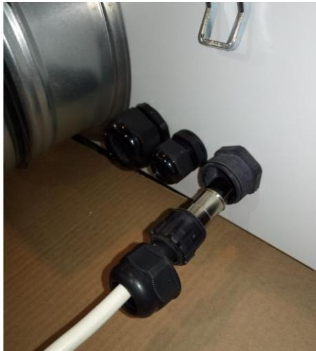
**Подключение кабеля питания вентилятора к приточной установке ВентБокс.**
